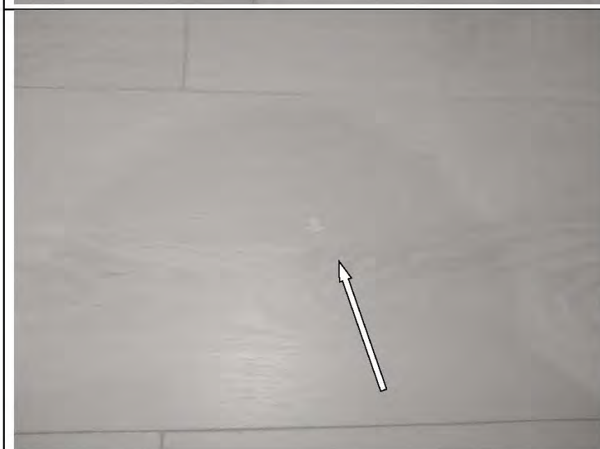
Фото №60. Загрязнение малярными составами досок ламината в гостиной.
