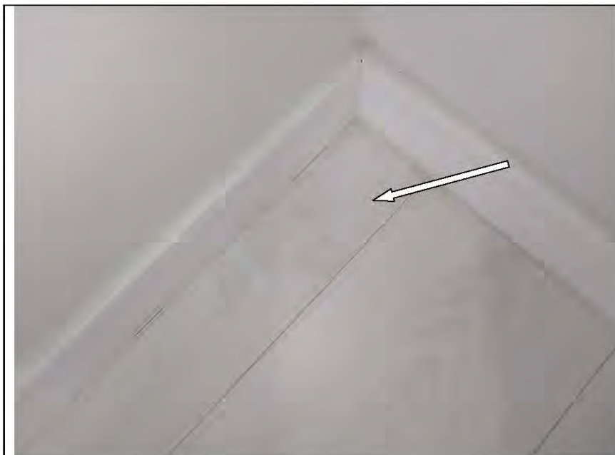
Фото №61. Загрязнение малярными составами досок ламината в спальне.
