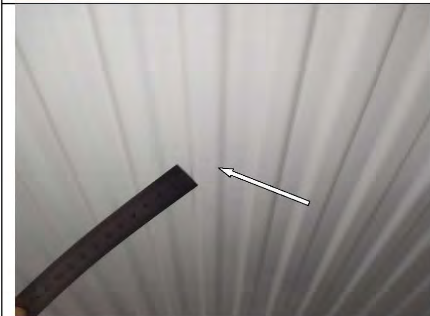
Фото №35. Отопительный прибор №1 имеет дефект покраски защитного кожуха в гостиной (царапины).
