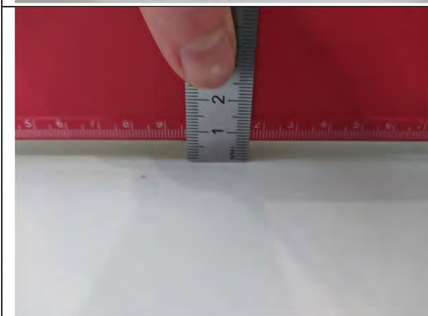
Фото №15. Измерения уровня напольного покрытия в кухне (керамическая плитка).
