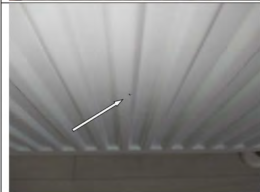
Фото №36. Отопительный прибор №2 имеет дефект покраски защитного кожуха в гостиной (скол).
